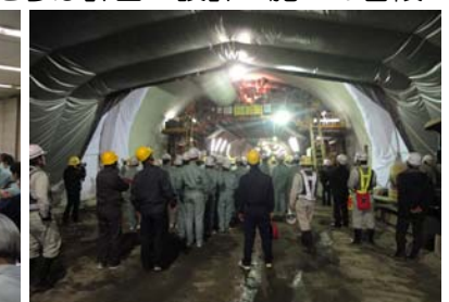
↑トンネル坑内を見学
