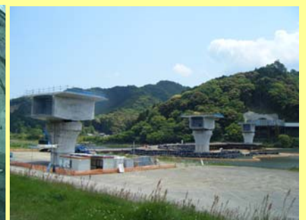
建設中の番匠川橋
