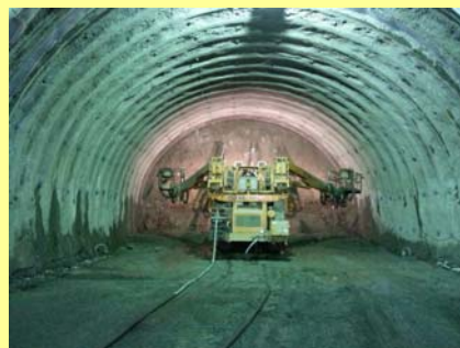
建設中の蒲江トンネル内部
