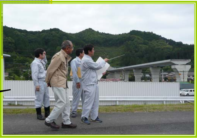
建設中の番匠川橋
