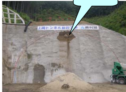
☆ロードヘッダーによる貫通の瞬間（明かり部より）
