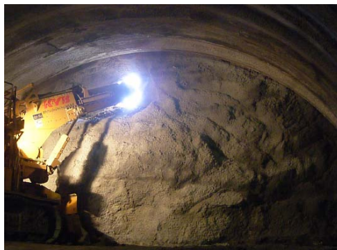
☆ロードヘッダーによる貫通の瞬間（坑内より）
