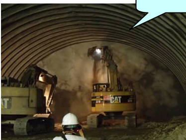
☆大型ブレイカによるトンネル貫通の瞬間
