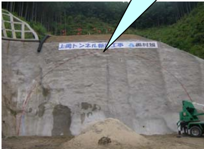
☆貫通前 （明かり部より）
