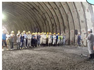
☆貫通作業披露会の様子
