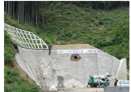
☆貫通後 （明かり部より）
