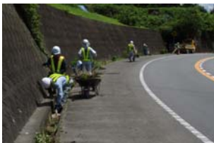
←側溝清掃様子
