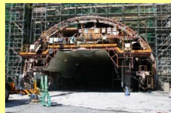
蒲江トンネル施工状況
