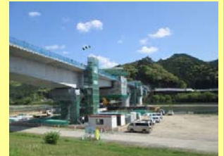
番匠川橋施工状況
