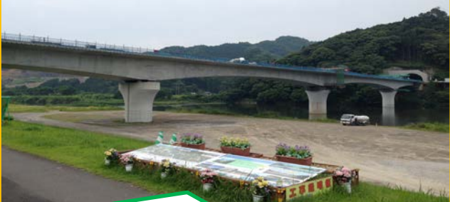
番匠川橋全景
