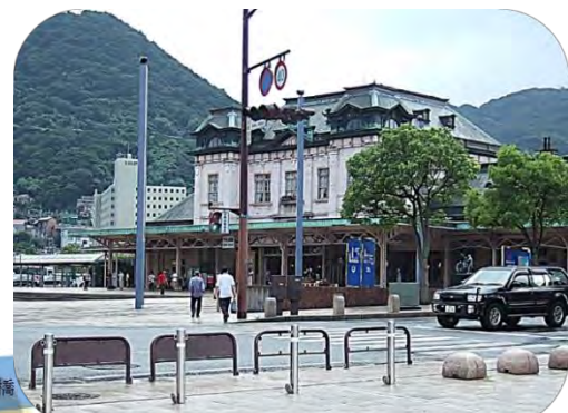
(1)九州鉄道の起点・門司港駅。1891年の開設。上記は2代目(1914年、国重要文化財。北九州市門司区)
