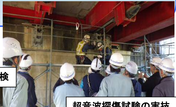
超音波探傷試験の実技
