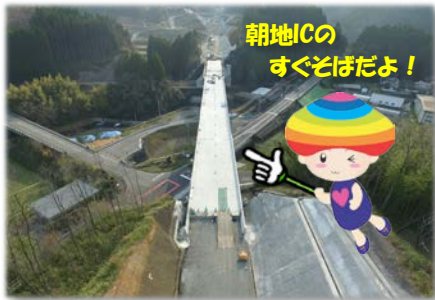
▲空から見た平井川橋
