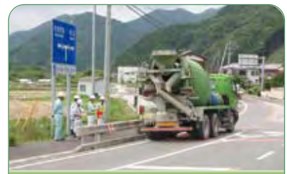
工事車両の運行状況パトロール
