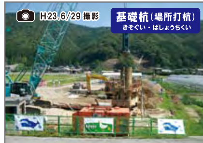
基礎を支えるための杭を土中に造ります。
