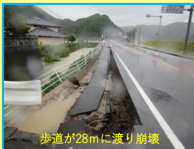
【歩道崩壊箇所（H29.9.17被災）】
