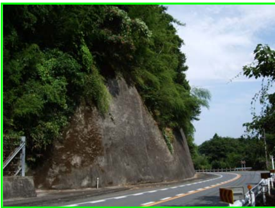
対策箇所全景（57号竹田市渡瀬）
