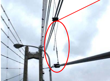
制振ワイヤの破断
