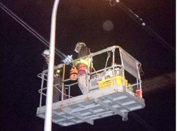
制振ワイヤの取り替え工事の状況
