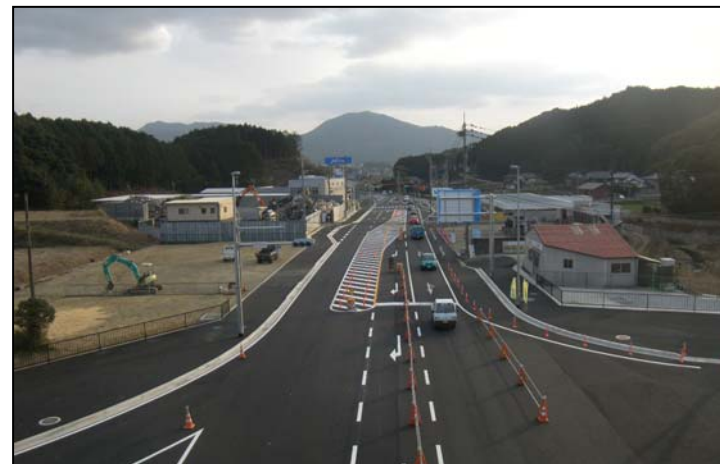
▲整備状況（大坪地区）【写真①】
