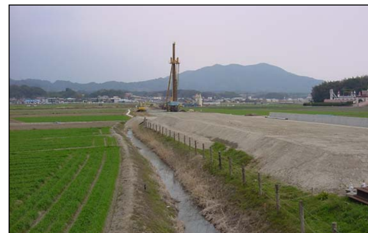
▲整備状況（大崎地区）【写真②】
