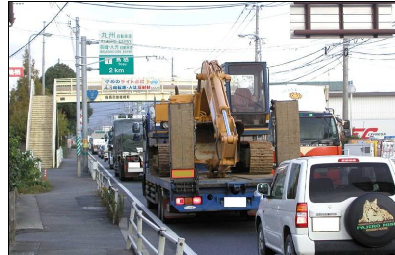
▲現地状況（曾根崎交差点付近）【写真①】
