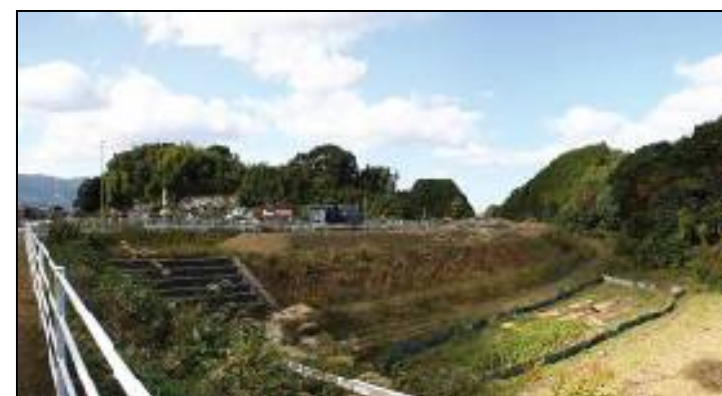
▲現地状況 (伊万里中 IC 予定地) 【写真②】
