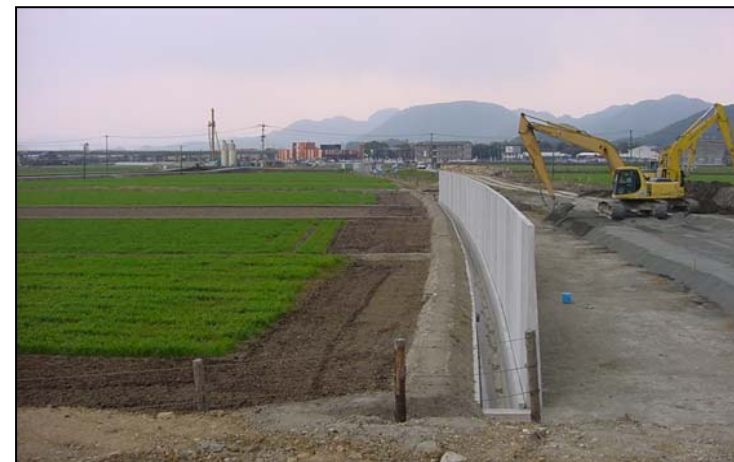
▲整備状況（大崎地区）【写真①】
