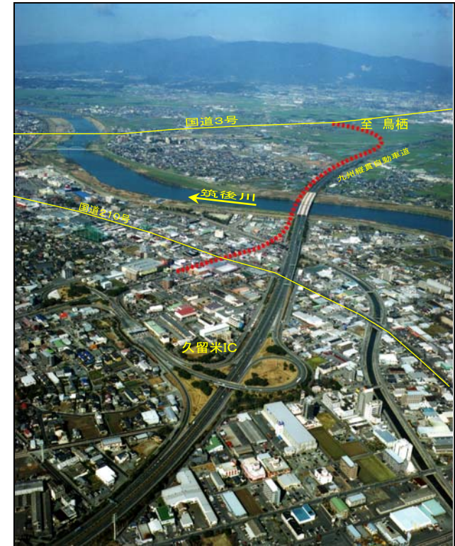
▲鳥栖久留米道路【写真①】
