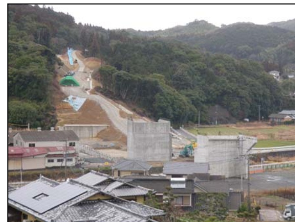
▲整備状況（浦之崎地区）【写真①】
