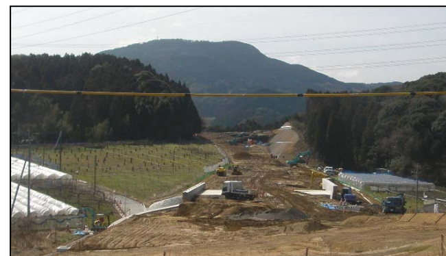
▲整備状況（重橋地区）【写真②】
