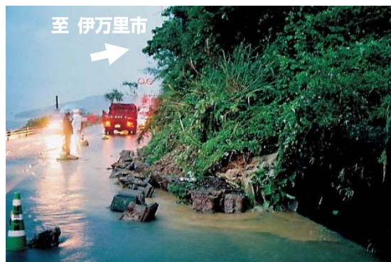
▲ 国道 204 号土砂災害状況
