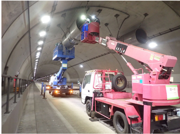
＜トンネル設備点検＞
