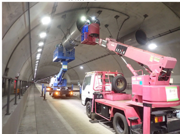
<トンネル設備点検 イメージ>
