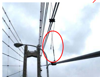
制振ワイヤの破断
