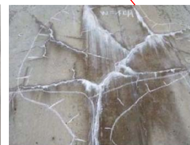
P7橋脚部のひび割れ
