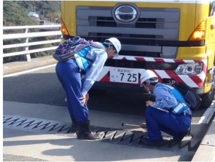
【伸縮装置の近接目視】
