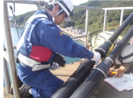
【定着部の近接目視】
