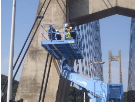
【高所作業車を用いた点検状況】
