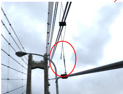
【制振ワイヤの破断】
