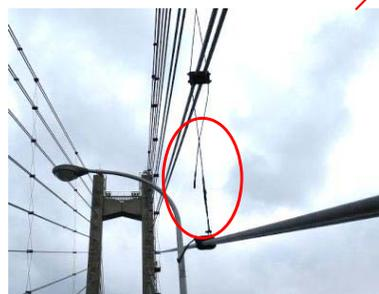
制振ワイヤの破断
