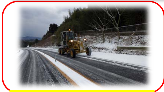
除雪作業状況(平成29年2月11日)
