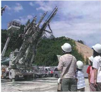
大きなトンネル工事車両
