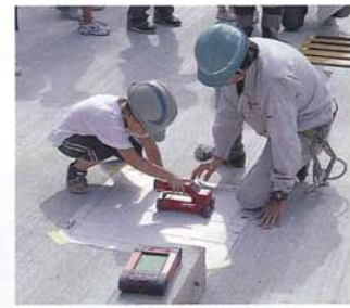
鉄筋非破壊検査体験
