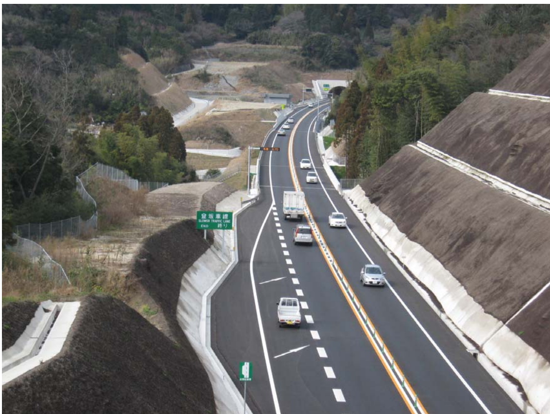
唐津道路（二丈鹿家 IC～浜玉 IC 間）唐津方面→福岡方面
