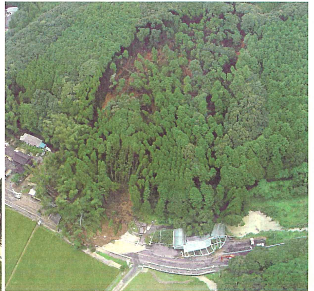
国道202号伊万里市府招地区被災状況 9月16日撮影
