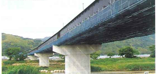
■松浦川大橋付近 (H19.5.21撮影)
