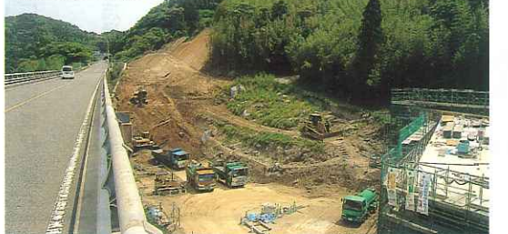
■谷口高架橋 (H19.5.21撮影)
