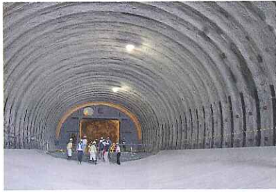
掘削後のトンネル内
