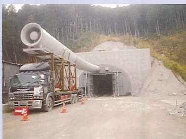
▲養母田トンネル坑口付近(唐津側) (唐津市養母田)
