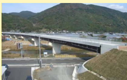
▲②谷口高架橋(仮称)
