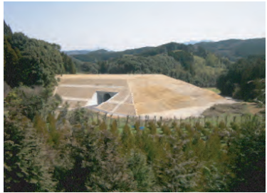
▲⑥府招地区施工状況
