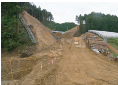
▲⑤廣田地区施工状況
