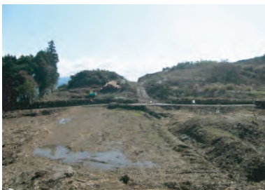
▲⑦久原地区施工状況
