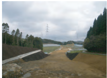
▲④重橋地区施工状況
