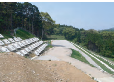
▲⑧立岩地区施工状況
