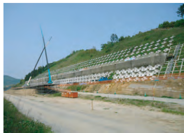
▲③北波多地区施工状況
