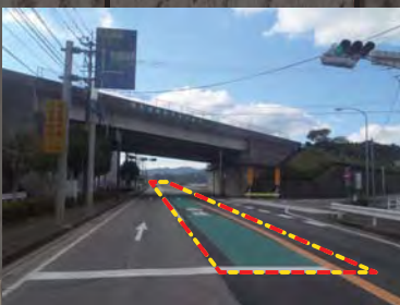
▲カラー舗装での路面表示
