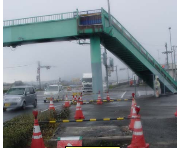
階段部撤去後
