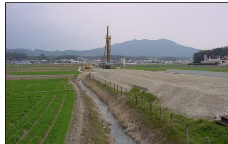
▲整備状況（大崎地区）【写真②】
