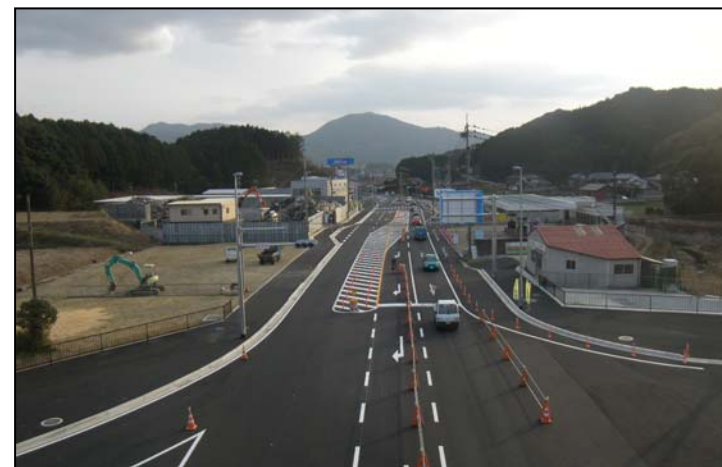
▲整備状況（大坪地区）【写真①】
