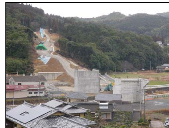
▲整備状況（浦之崎地区）【写真①】
