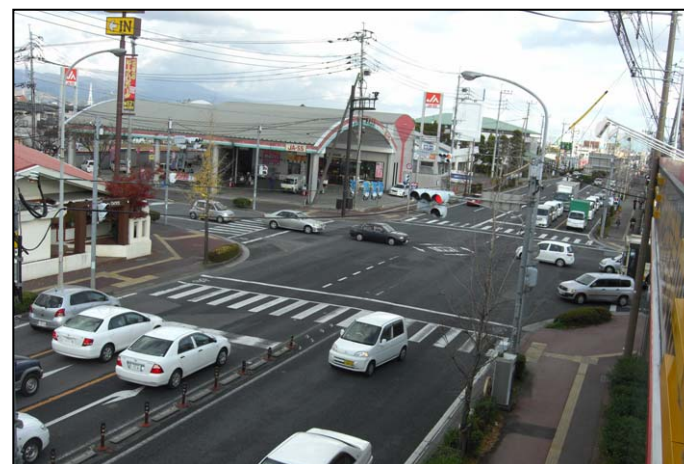
▲現況（佐賀地区電線共同溝）【写真①】
