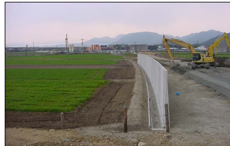
▲整備状況（大崎地区）【写真①】
