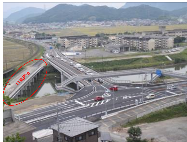
▲整備状況（川原橋交差点改良済）【写真①】
