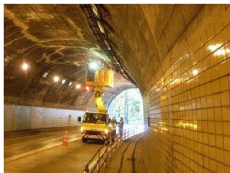
照明点検状況
