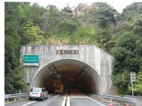
照明点検状況
