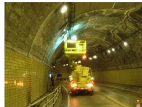
照明点検状況
