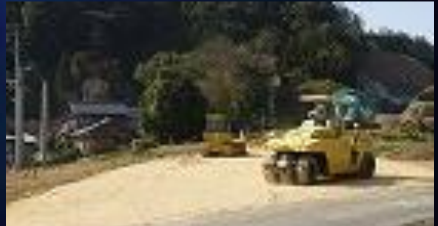
盛土（ブルドーザー・タイヤローラ）
