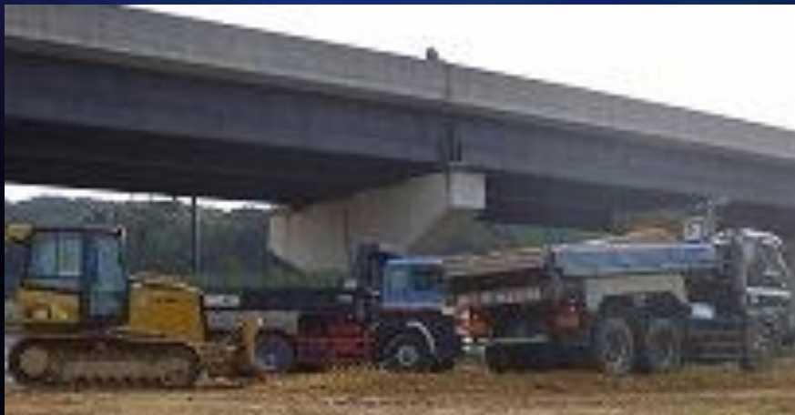
盛土（ブルドーザー・ダンプトラック）
