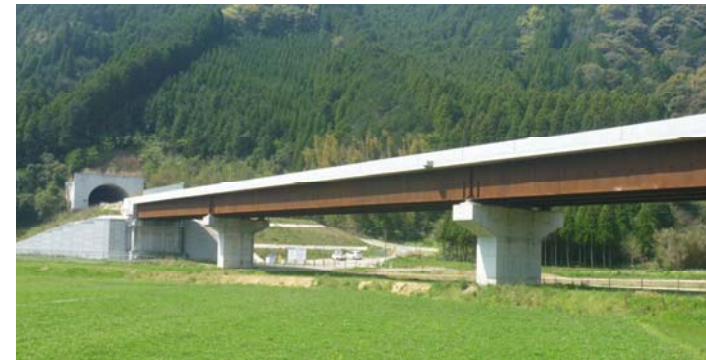
▲整備状況①（山彦橋）【写真①】
