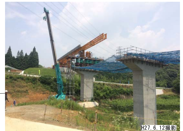
整備が進む古里 2 号橋 (仮称)
