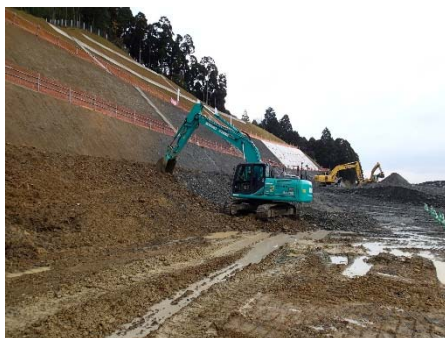
MCバックホーによる切土法面整形
