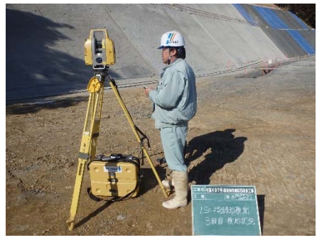
レーザースキャナーによる出来形測量
