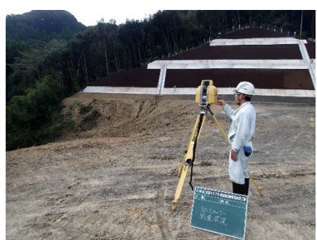
レーザースキャナーによる起工測量
