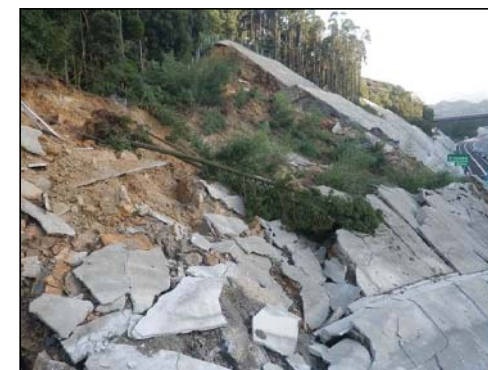
終点側崩壊箇所
