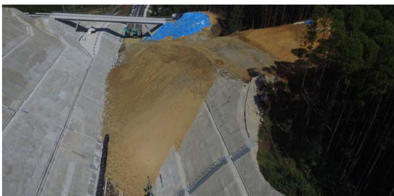
被災地全景(終点側より)
