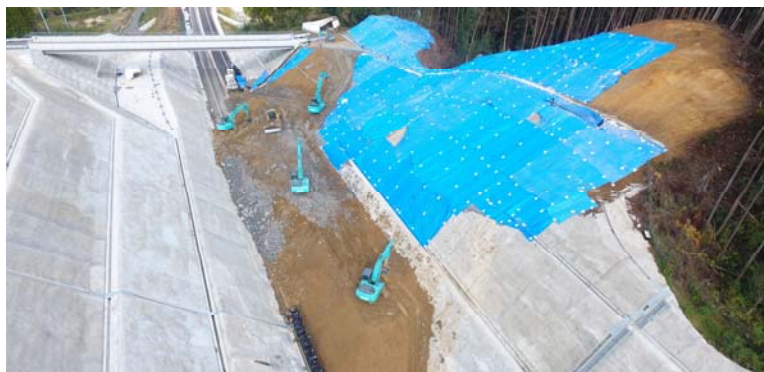
被災地全景(終点側より)
