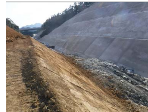
崩壊下方の盛土状況
