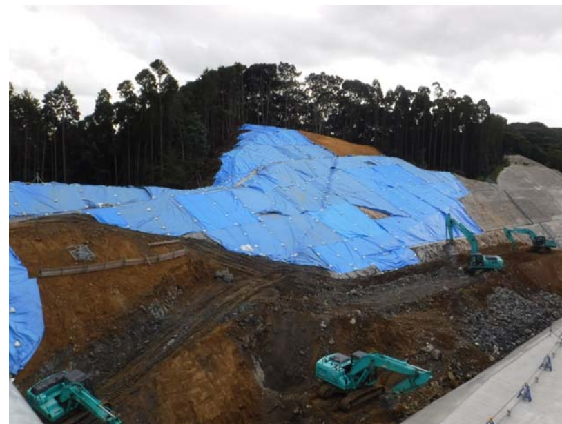
掘削作業状況
