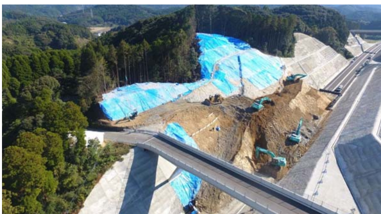
被災地全景(起点側より)
