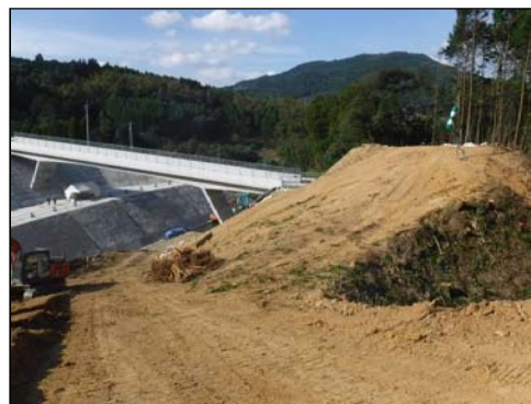
頭部から起点側を望む
