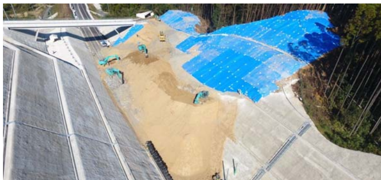
被災地全景(終点側より)
