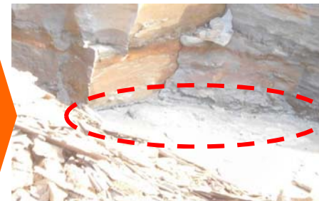
すべり面の状況
