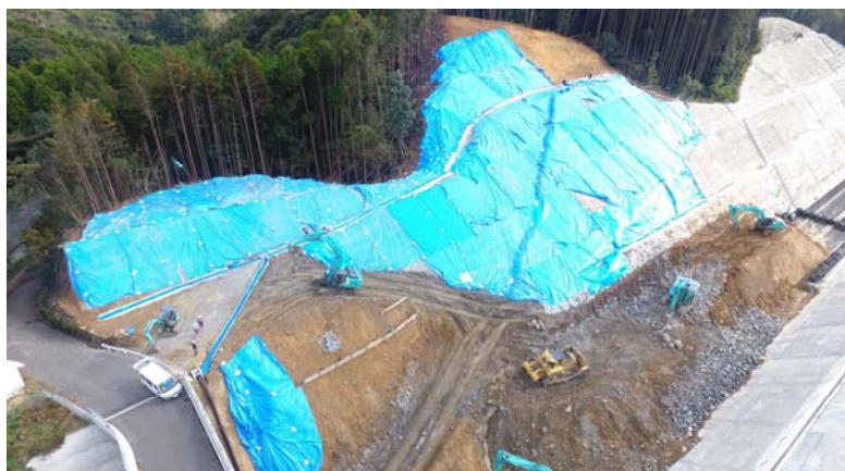
被災地全景(起点側より)
