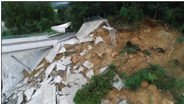
起点側崩壊箇所
