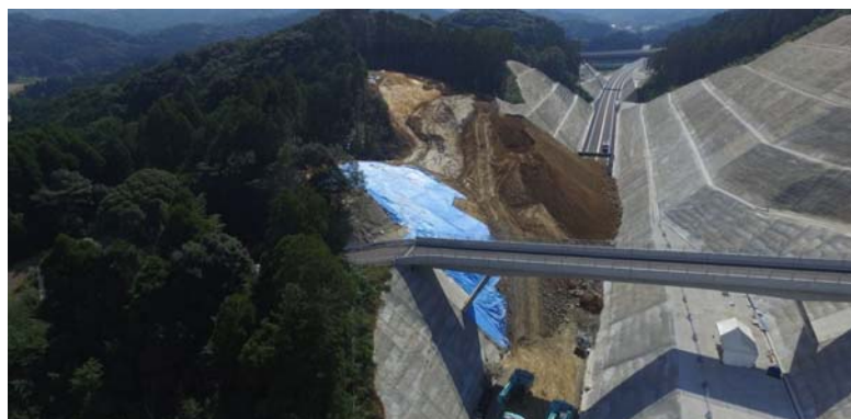
被災地全景(起点側より)
