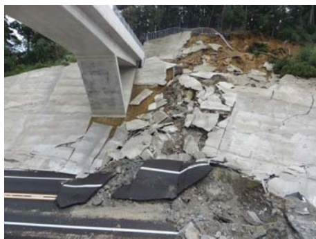
起点側崩壊箇所
