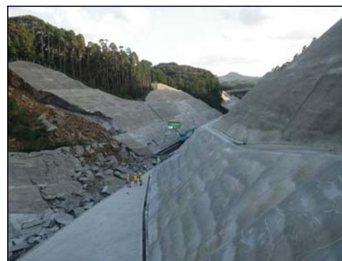
起点側より終点側を望む
