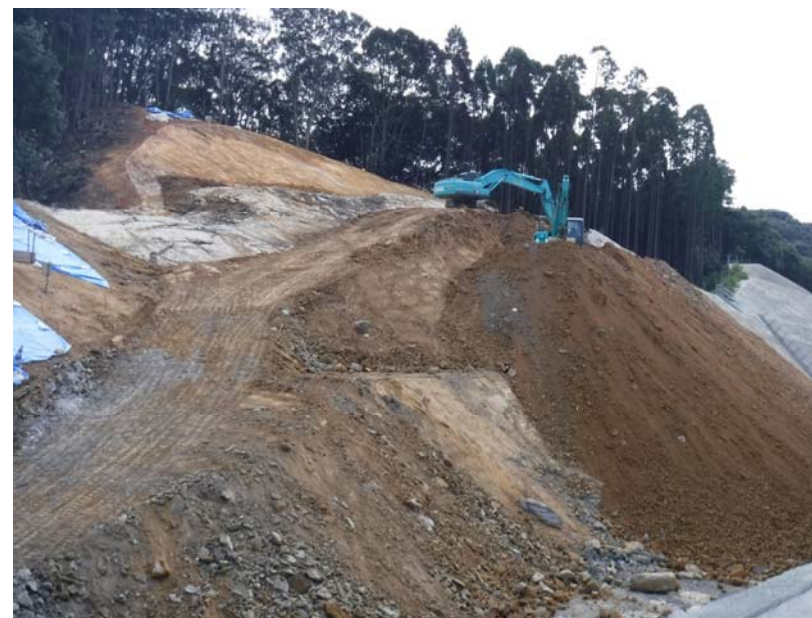
掘削作業の状況
