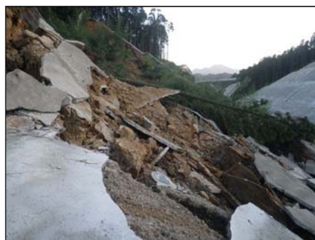
起点側崩壊箇所
