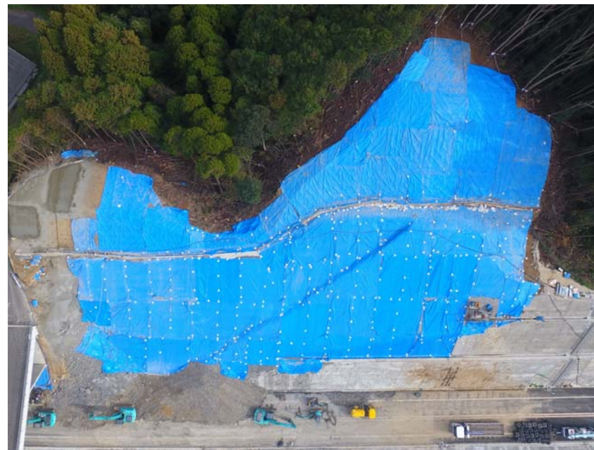
被災地全景(掘削部拡大)
