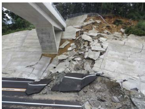
起点側崩壊箇所
