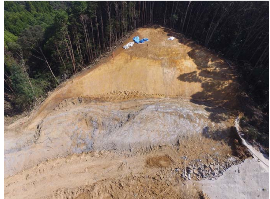
被災地全景(掘削部拡大)
