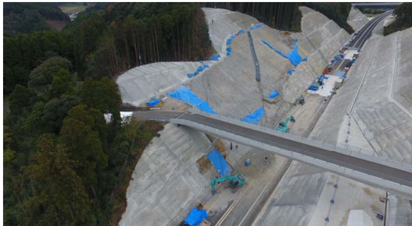
被災地全景(起点側より)
