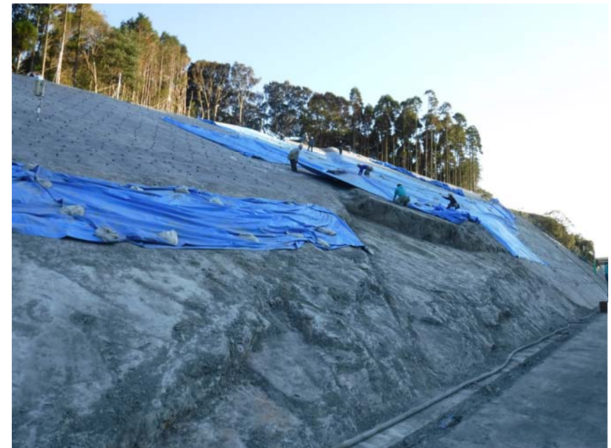
法面作業状況
