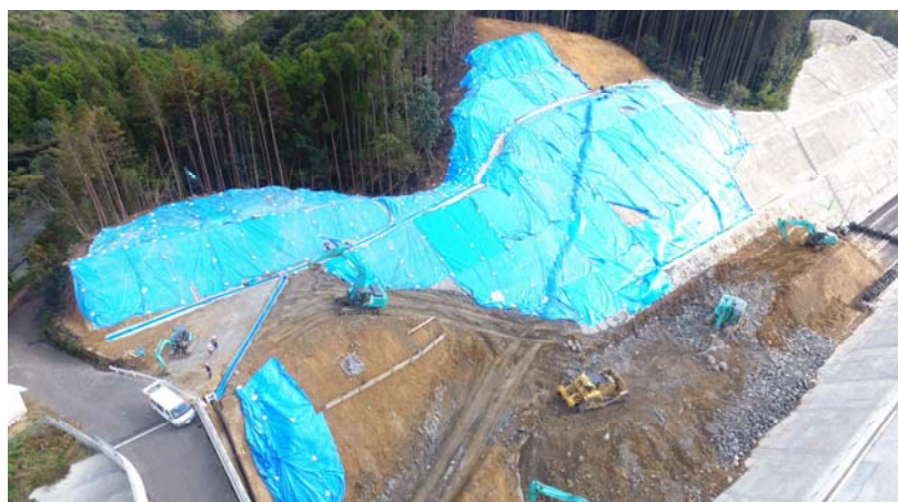
被災地全景(起点側より)
