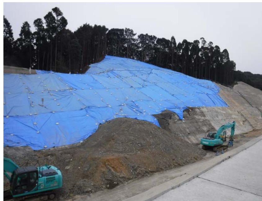
掘削作業状況
