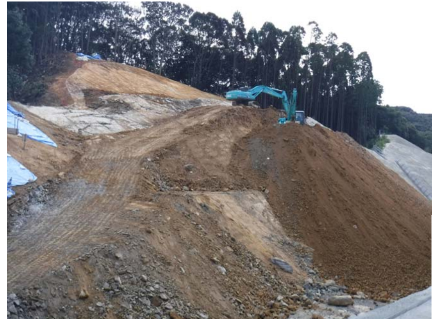
掘削作業の状況
