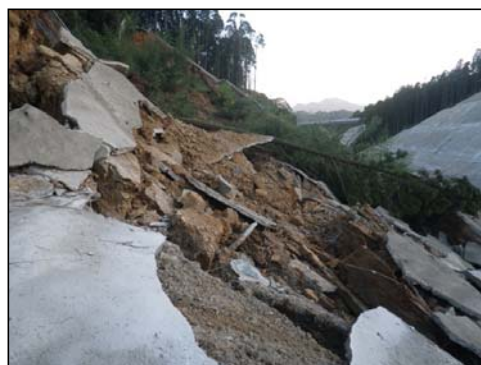
起点側崩壊箇所
