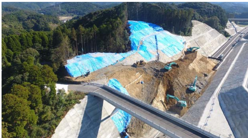
被災地全景(起点側より)
