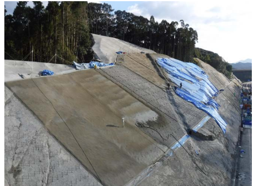
法面作業状況
