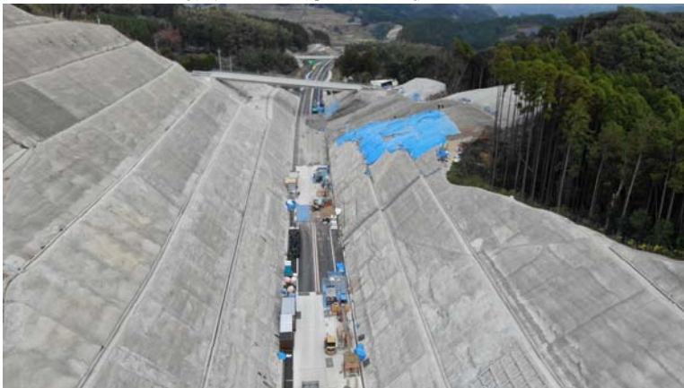
被災地全景(終点側より)
