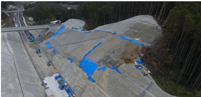
被災地全景(終点側より)
