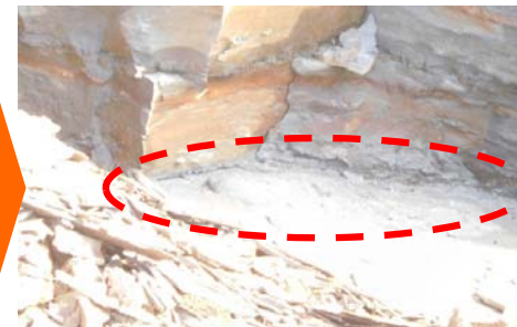
すべり面の状況
