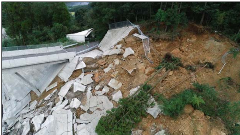
起点側崩壊箇所
