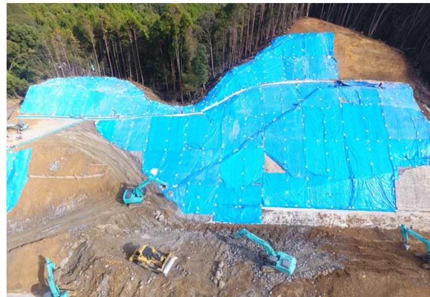
被災地全景(掘削部拡大)
