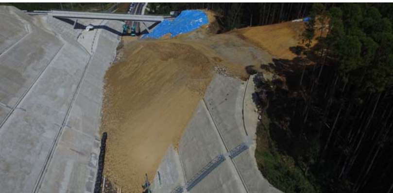
被災地全景(終点側より)
