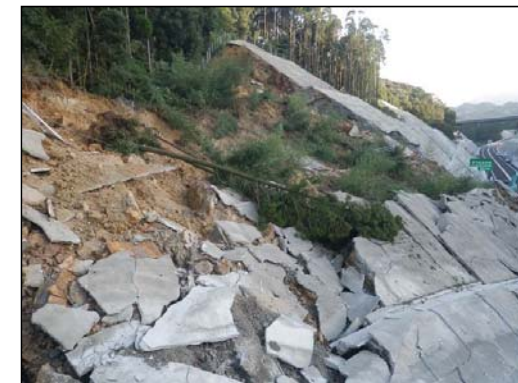
終点側崩壊箇所
