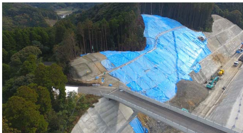
被災地全景(起点側より)
