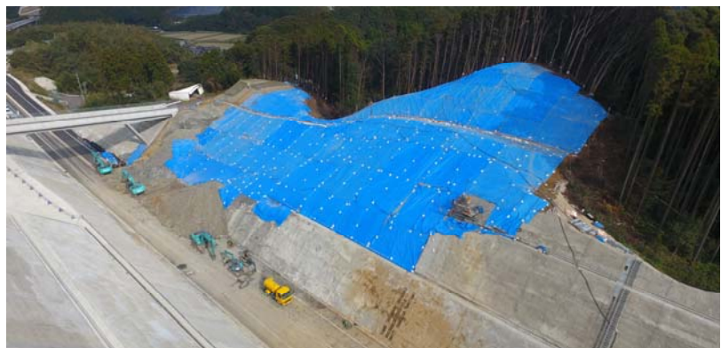
被災地全景(終点側より)
