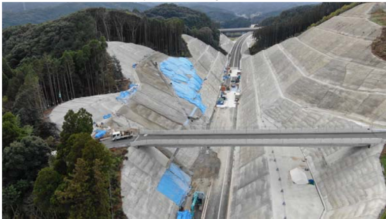
被災地全景(起点側より)
