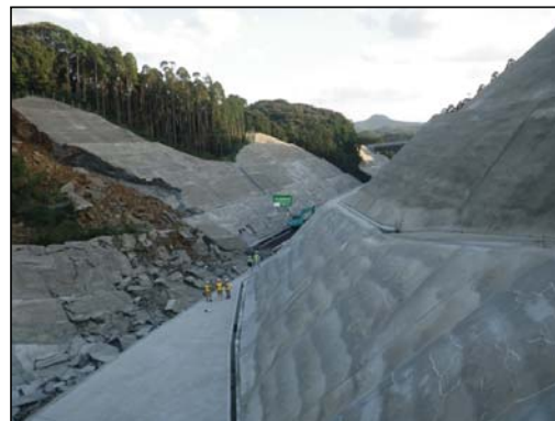
起点側より終点側を望む
