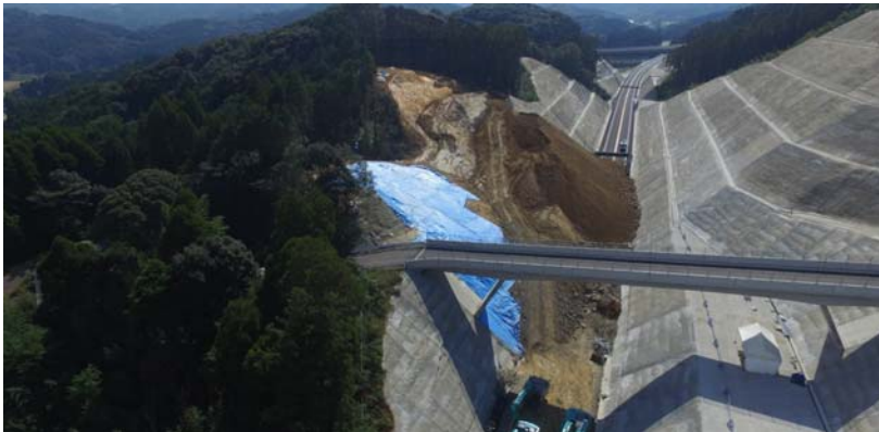
被災地全景(起点側より)
