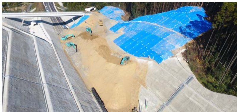
被災地全景(終点側より)
