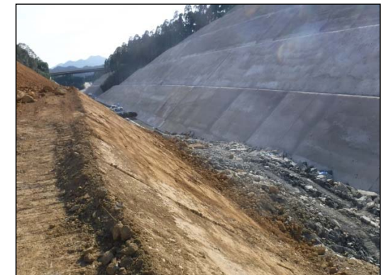
崩壊下方の盛土状況
