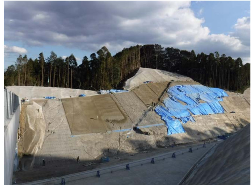
法面作業状況
