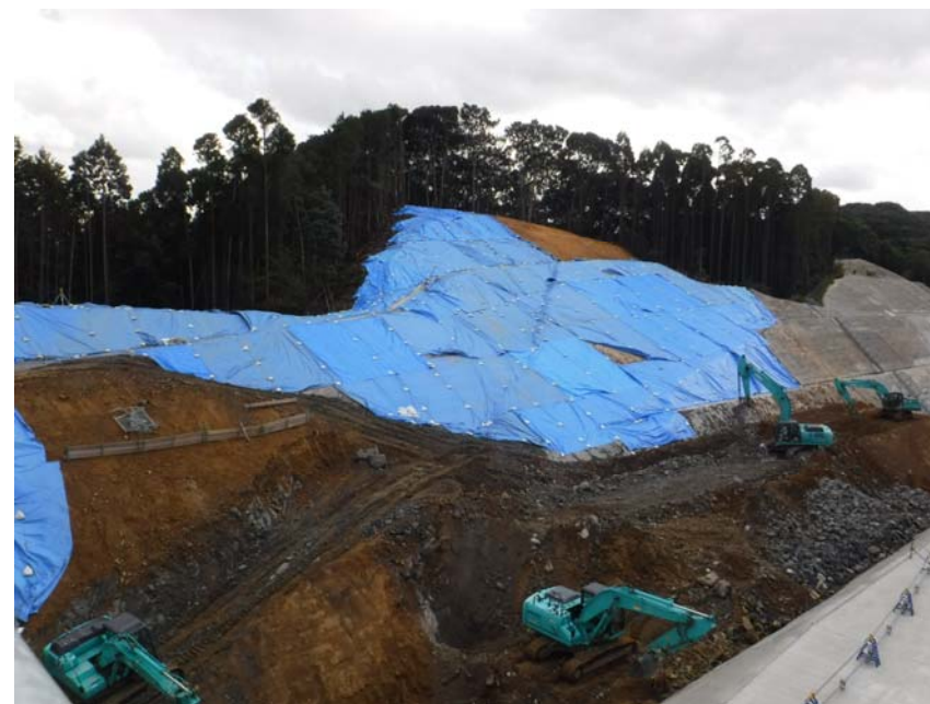
掘削作業状況
