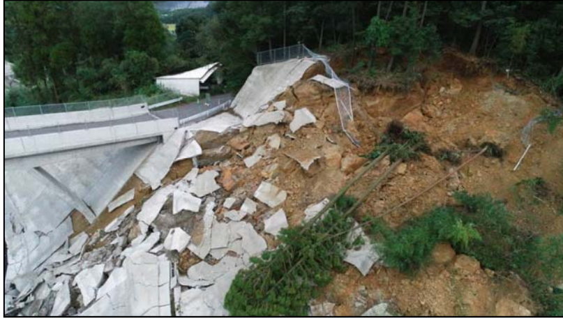
起点側崩壊箇所
