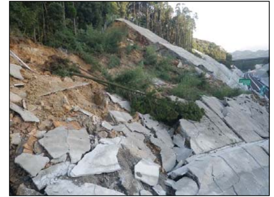
終点側崩壊箇所
