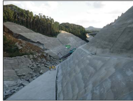
起点側より終点側を望む
