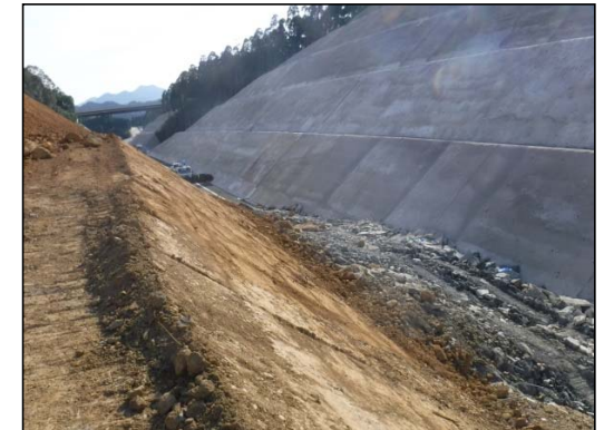
崩壊下方の盛土状況
