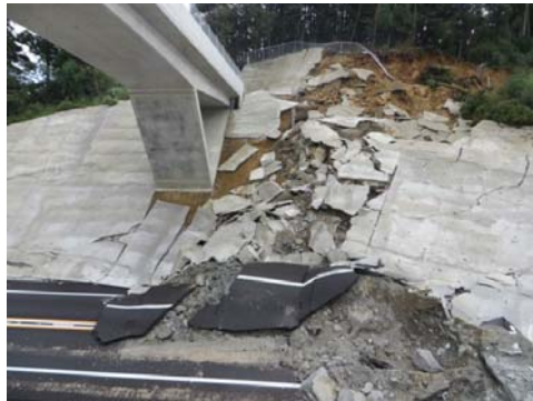
起点側崩壊箇所
