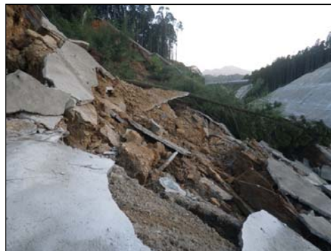
起点側崩壊箇所
