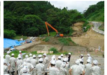
【工事現場での説明】
