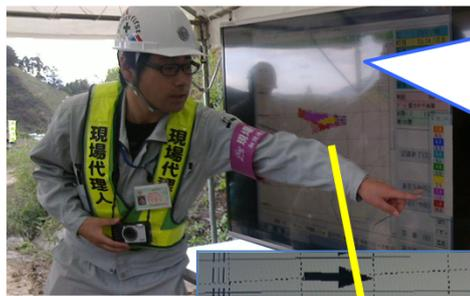
転圧管理は、タイヤローラー運転席のディスプレイに、転圧回数毎に色分けした平面図が表示されます。どの場所を何回転圧したかが一目でわかり、転圧忘れを防げます。
