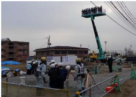
高所作業車の試乗中
