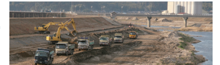
菱刈地区掘削工事
