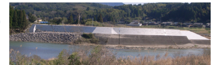
荒瀬地区嵩上げ工事
