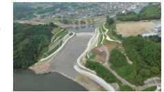
推込分水路工事
