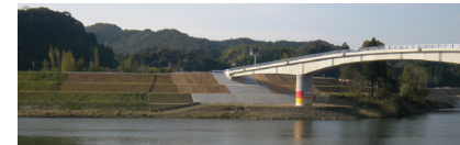
久住地区橋梁工事(薩摩川内市事業)
