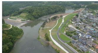
完成後の虎居地区堤防・推込分水路周辺
