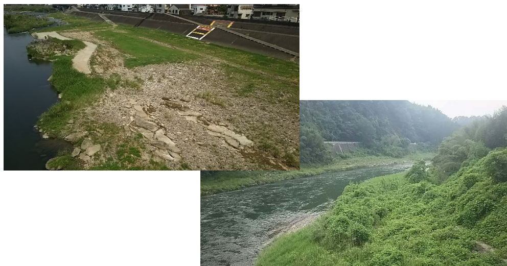
安全な水辺へのアクセス、安全な利用ができない状況
