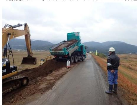
羽月川の掘削土を湧水町吉松地区堤防強化工事の盛土材として再利用
