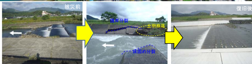
加久藤第4床固め 被災状況(H23.7.6被災)
