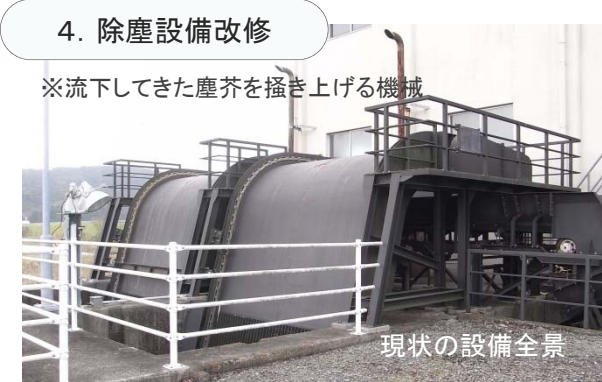
除塵設備本体の耐腐食性能向上(ステンレス化)及び設備構成機器更新等
