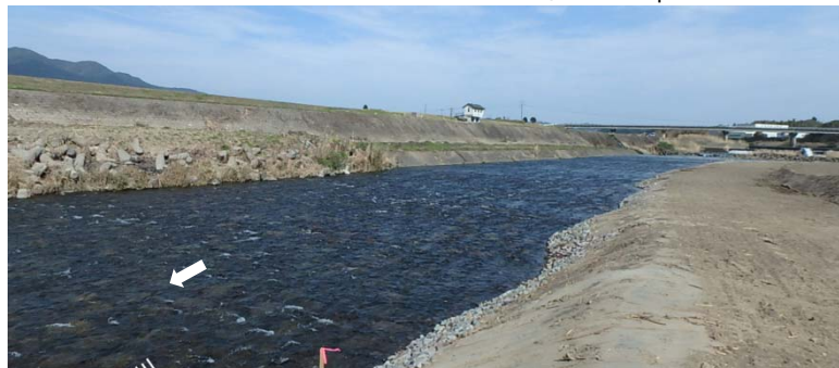
施工完了状況(111k600付近) H28.3月
