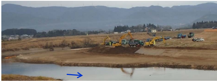
河道掘削（第一段階）施工状況（羽月川左岸1k800付近）
