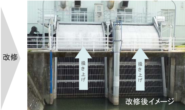
除塵設備本体の耐腐食性能向上(ステンレス化)及び設備構成機器更新等
