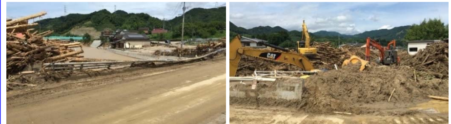
福岡県赤谷川被害状況
