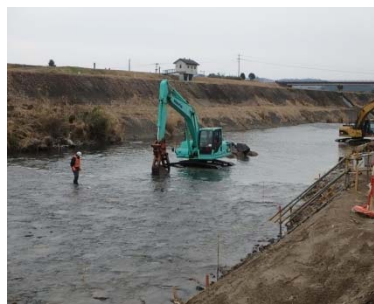
巨石据付状況(φ700~1000)
