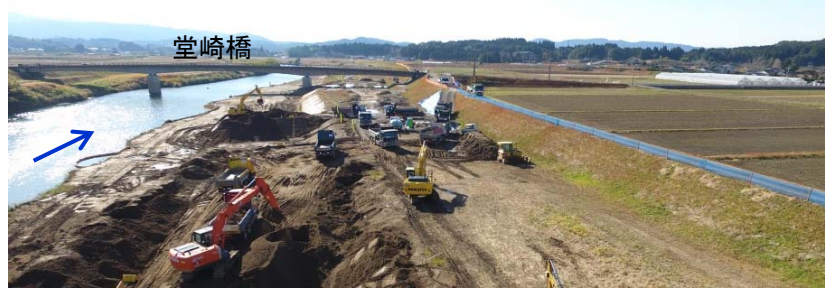
河道掘削（第一段階）施工状況（羽月川右岸1k300付近）
