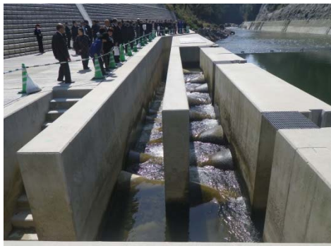
魚道設置状況（ハーフコーン型魚道）
