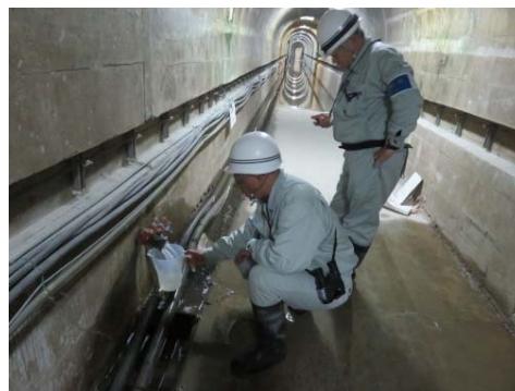
堤体の挙動観察（漏水量測定）の状況
