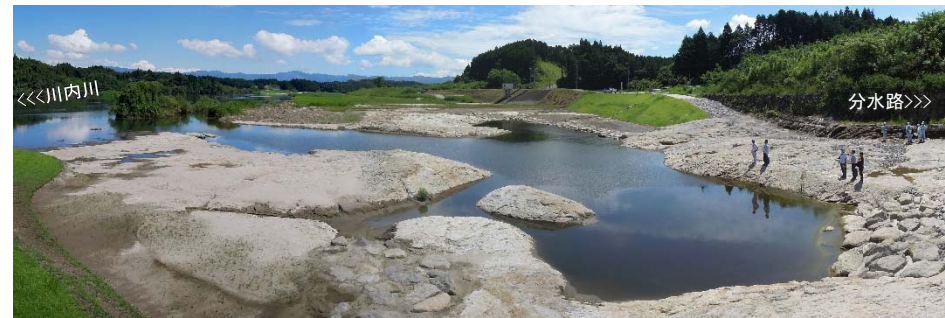
切り下げ完了後の呑口全景
