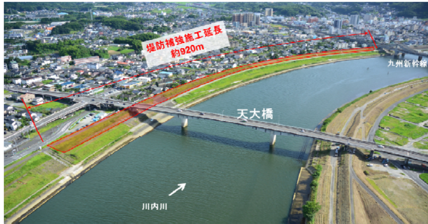
堤防補強実施箇所（白和地区）
