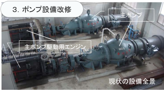
主ポンプの整備・改造及び主ポンプ駆動用設備(エンジン・減速機)の更新等
