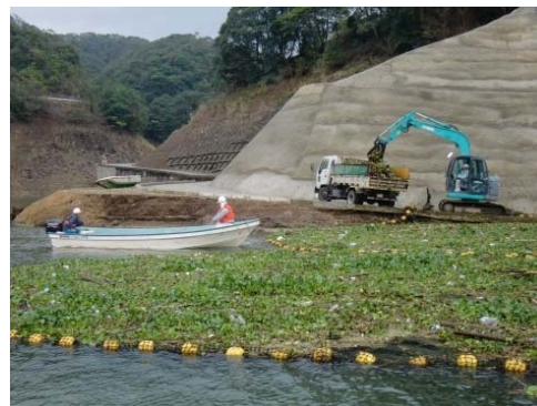
流木塵芥処理の状況
